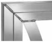
Alle Profilstöße werden in handwerklicher Präzisionsarbeit verschweisst.
